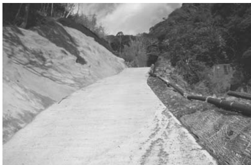
(浜尻地区、林地 荒廃防止事業)
