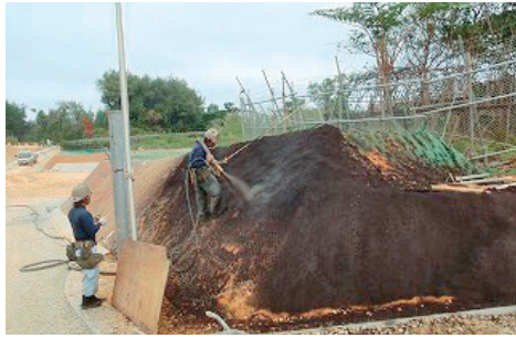
「法面保護施工の一例」
