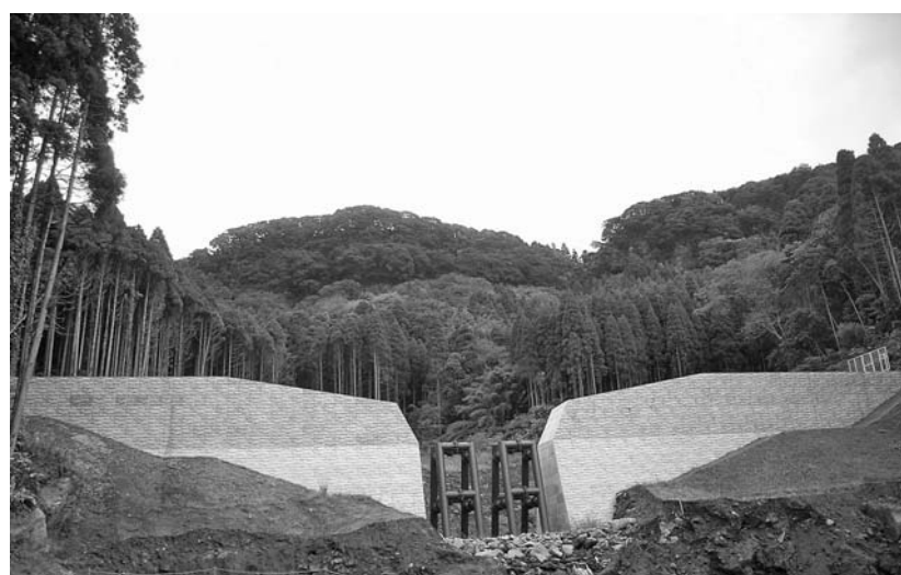
根占地区（久保下ダム）
