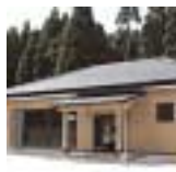
■ 建設中の 中別府公民館
