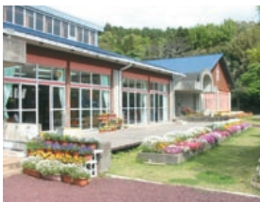
昭和61年竣工の校舎
