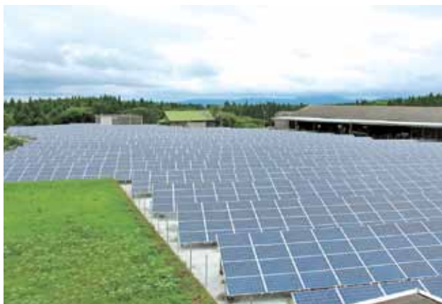
設置されたソーラーパネル
