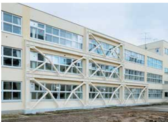
トグル制震構法による耐震補強
