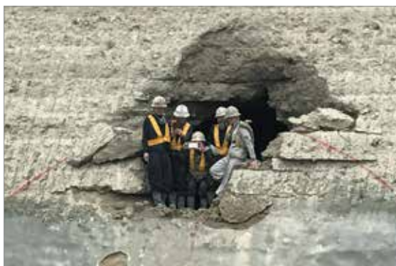
打ち破られた外壁から貫通を告げる工事関係者
