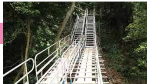
佐多岬公園に設置された仮設道路の階段
