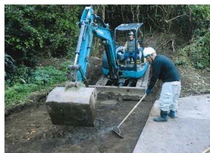
(ハウス作業用通路整備)
