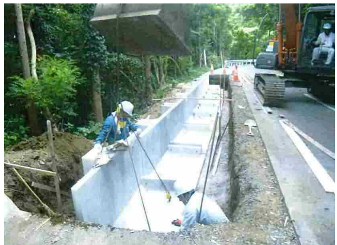
町道新設改良
