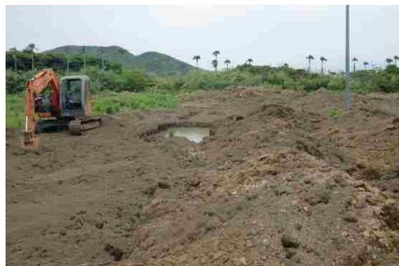
土壌改良作業
