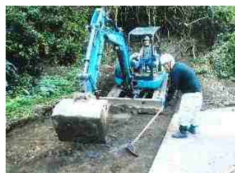
(ハウス作業用通路整備)
