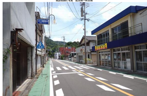
既設街路灯写真 起点側→終点側
