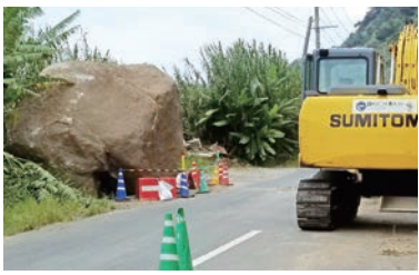
台風 25 号による落石 (伊座敷付近にて)
