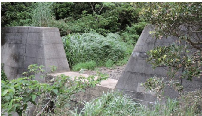
土砂で満杯の竹之浦砂防ダム
