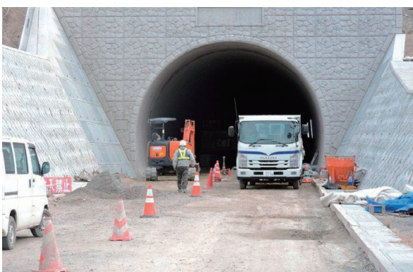
工事中の伊座敷トンネル
