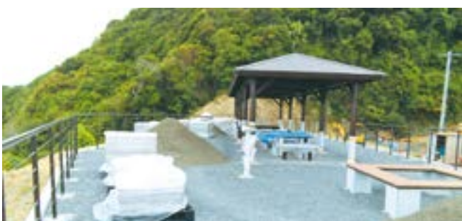
佐多岬エントランス広場施工状況
