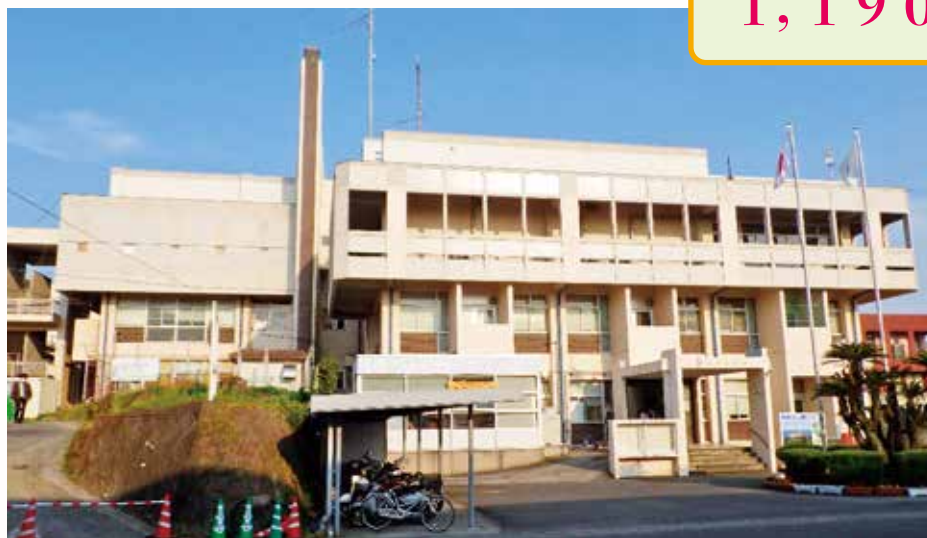
取り崩される現庁舎
