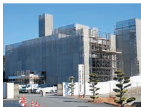
解体中の旧庁舎
