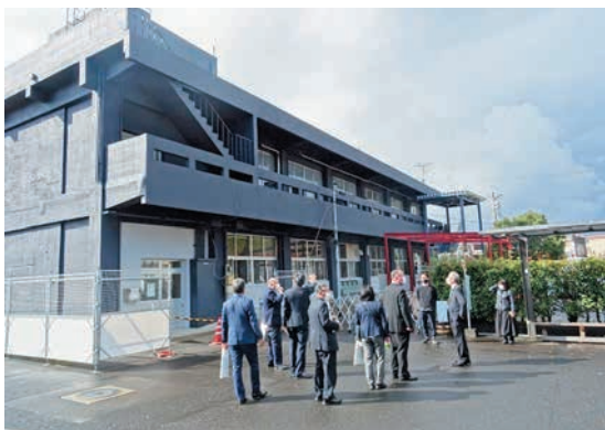
南九州市「整備中の旧川辺中学校廃校舎」
