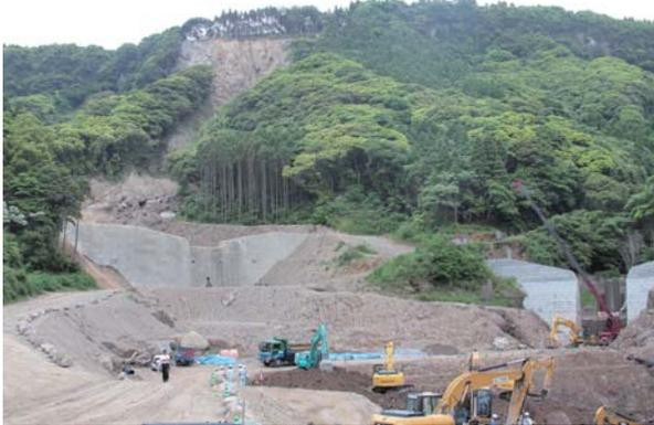
土石の除去が進む堰堤
