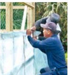
生活科園補修
