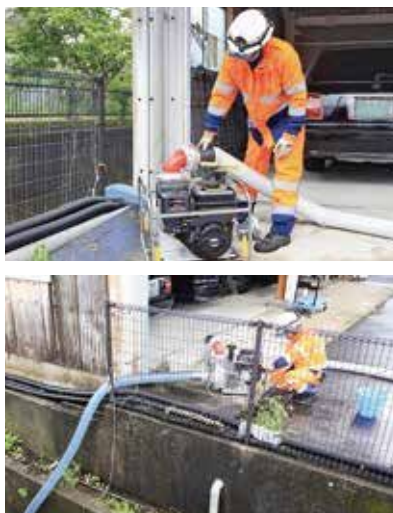
排水ポンプの操作状況
