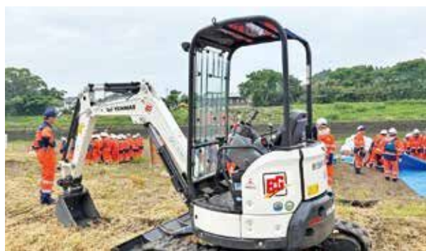
水防訓練で使用された災害対応重機
