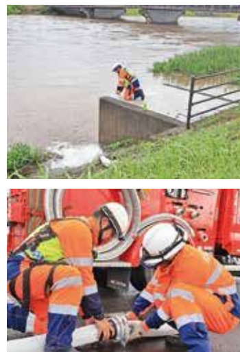
排水状況を確認する団員（写真上）と排水ホース確認作業（写真下）
