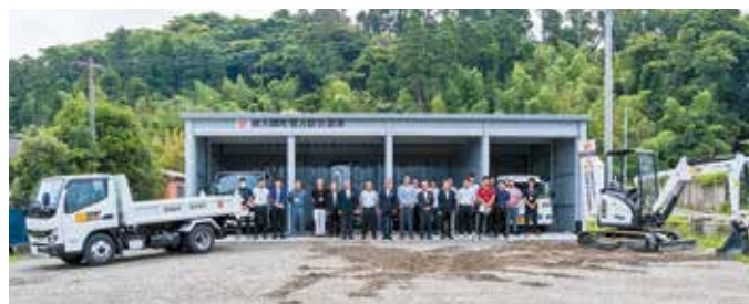
根占地区防災倉庫と配備機材
