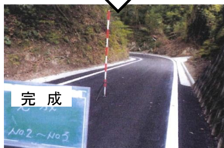
町道新設改良
