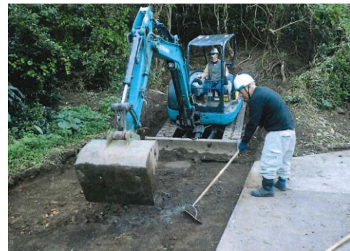
(ハウス作業用通路整備)
