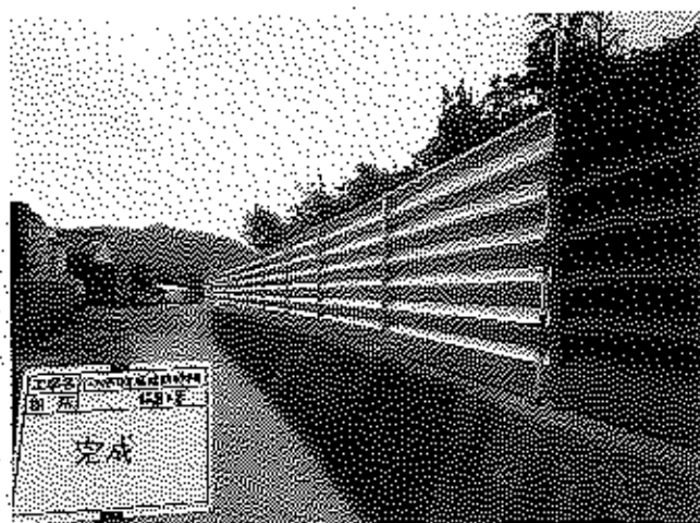
防砂柵設置工事
