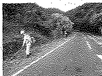
町道清掃作業委託
