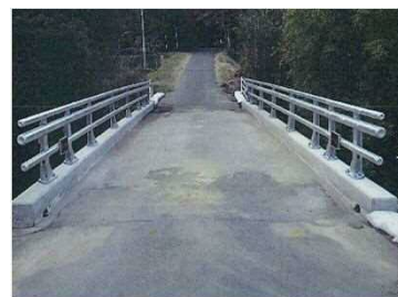
橋梁補修工事
