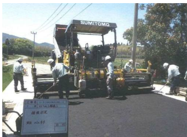
道路改良舗装工事
