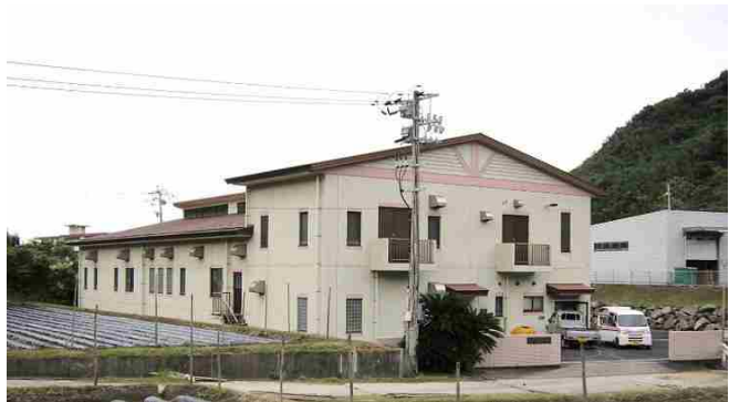
（農業集落排水污水施設）
